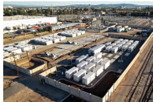
**5x 6MW/21MWh BESS**
