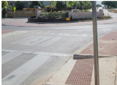
Ramps/ ADA Elements
